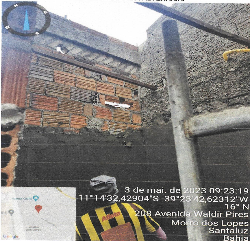
Foto 18- REBOCO DA ALVENARIA.
