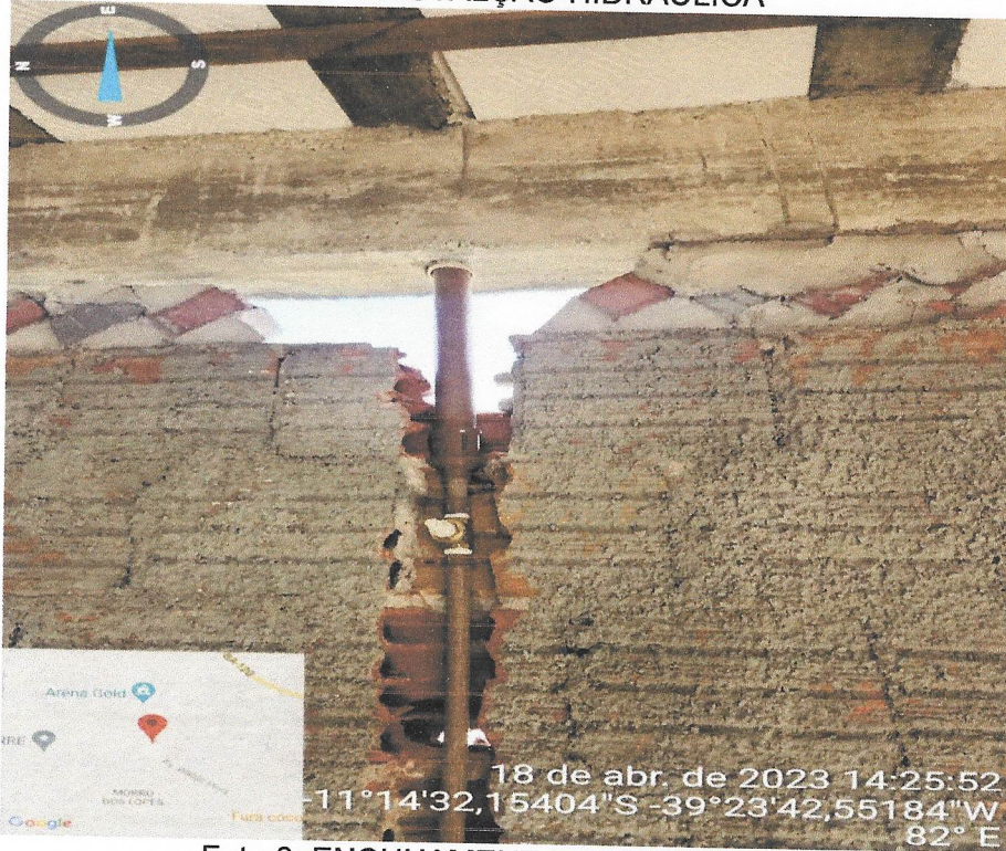
Foto 8: ENCHUAMENTO DAS PAREDES
