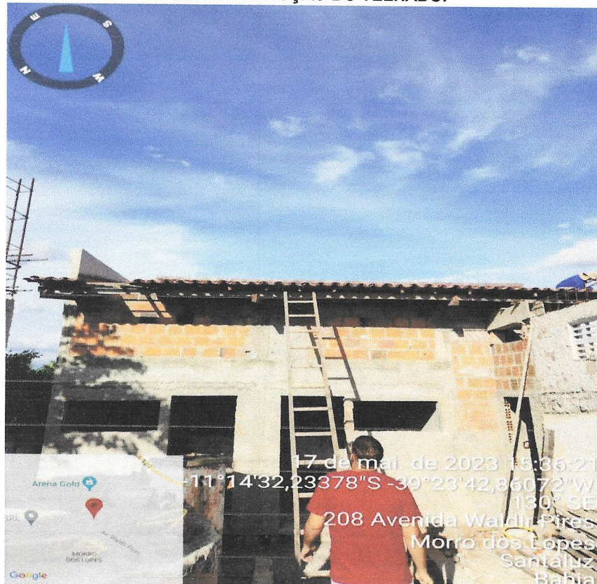
Foto 22- EXECUÇÃO DO TELHADO.
