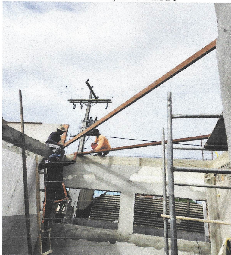
Foto 39- EXECUÇÃO DO TELHADO
