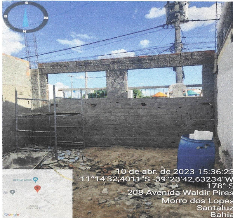
Foto 02 – CHAPISCO DAS PAREDES
