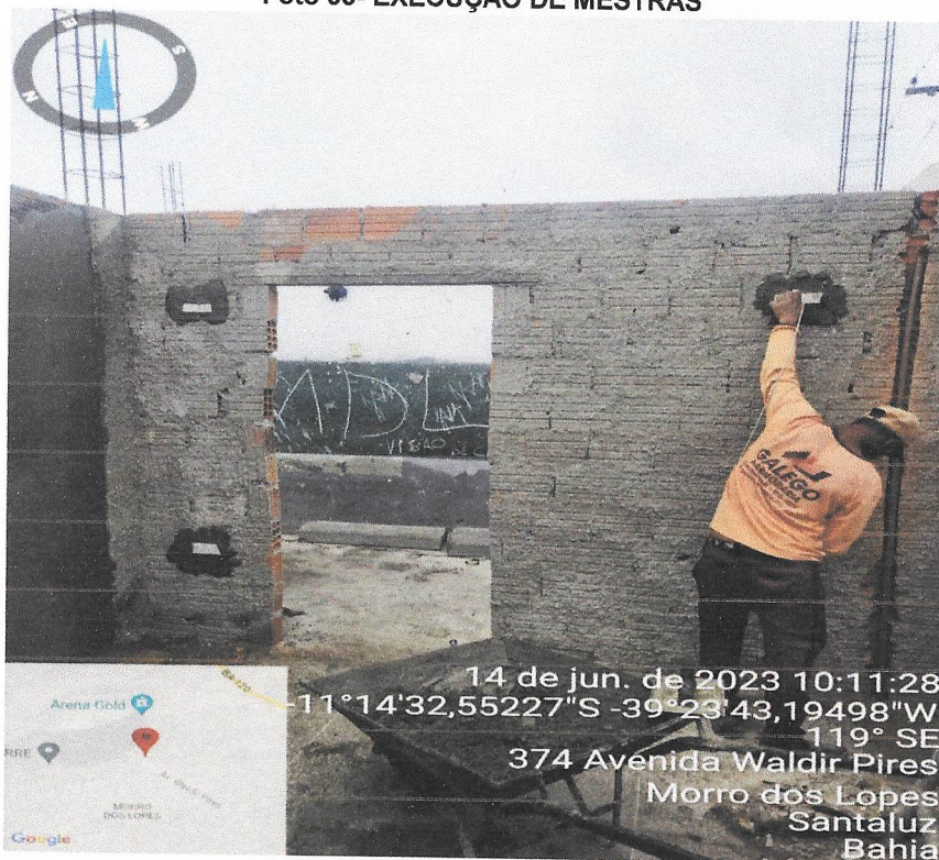
Foto 34- REBOCO DA ALVENARIA
