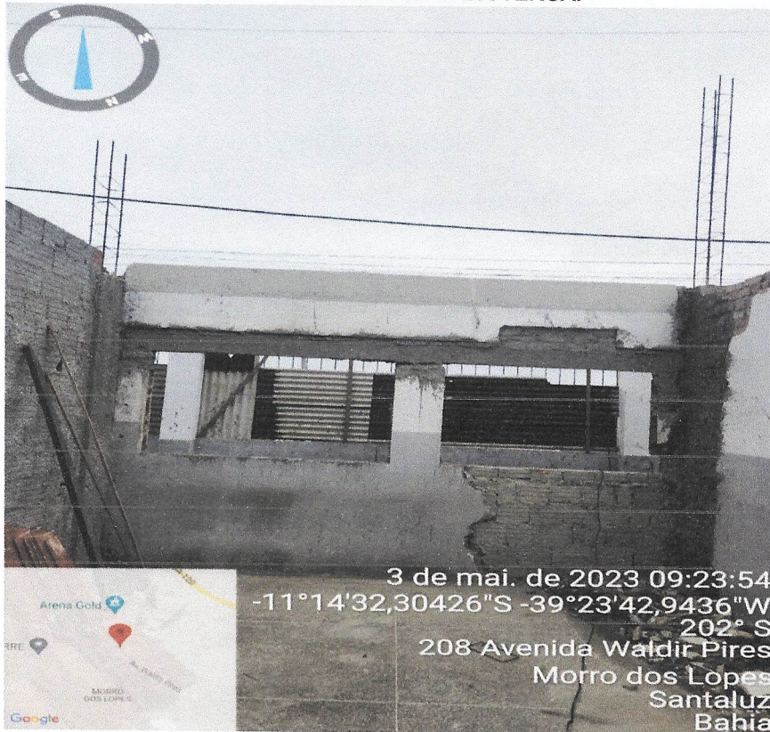
Foto 18- REBOCO DA ALVENARIA.
