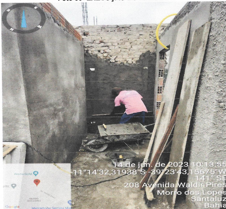
Foto 36- EXECUÇÃO DO REBOCO
