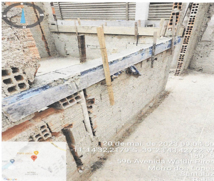
Foto 24- EXECUÇÃO DA CONTRAVERGA
