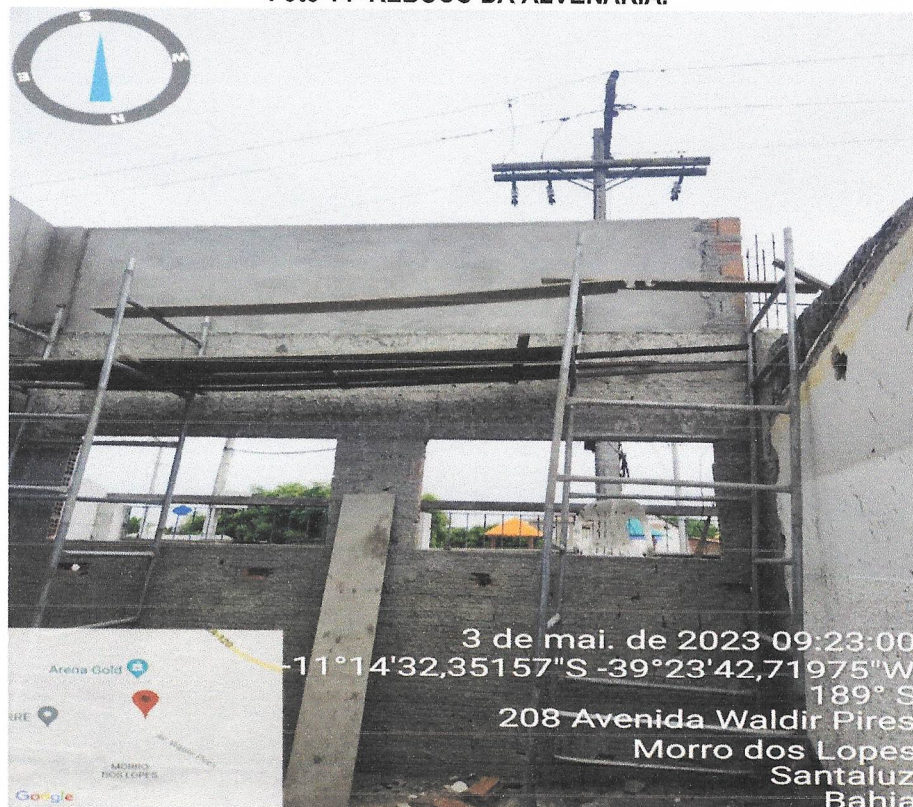
Foto 14- REBOCO DA ALVENARIA.
