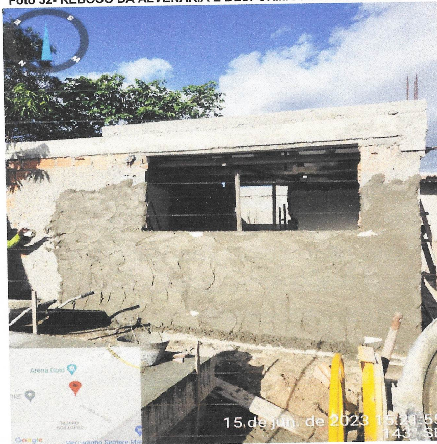
Foto 32- REBOCO DA ALVENARIA E DESFORMA DA LAJE DA COZINHA
