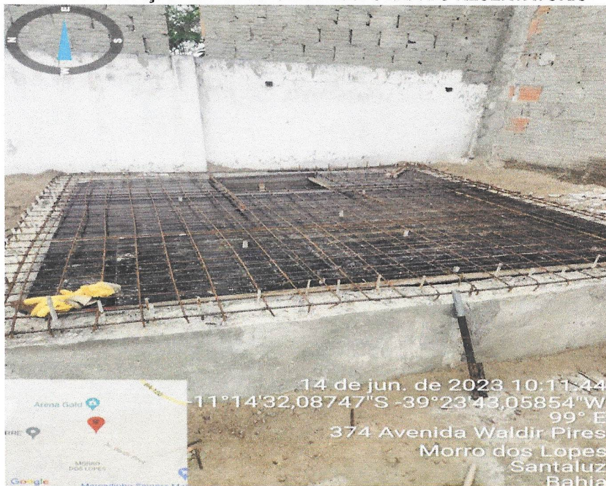
Foto 28- ARMAÇÃO DA FERRAGEM E DA FORMA DO RESERVATÓRIO
