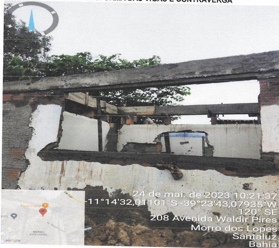
Foto 26- EXECUÇÃO DAS CONTRAVERGAS
