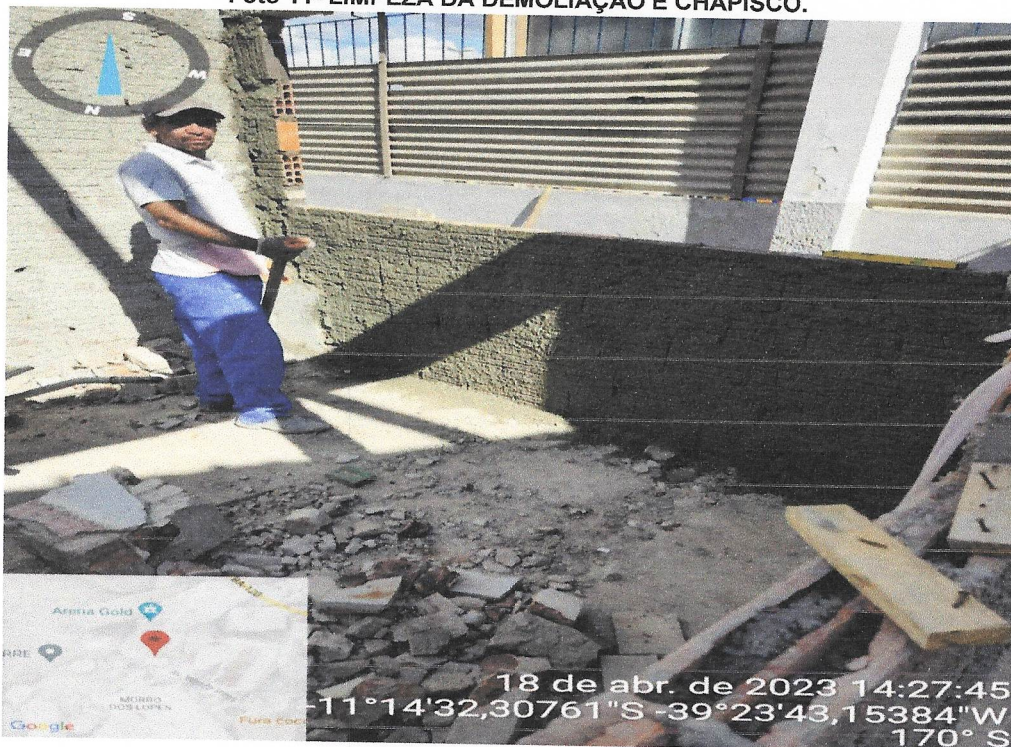
Foto 12- LEVANTE DE ALVENARIA.
