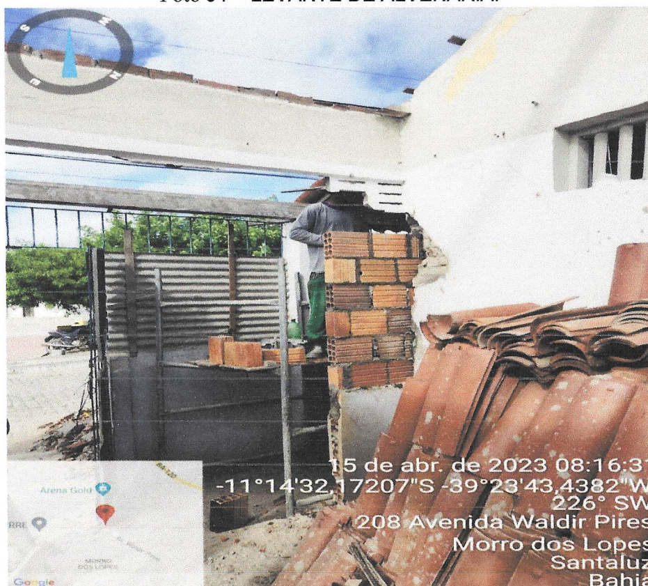
Foto 04 – LEVANTE DE ALVENARIA.
