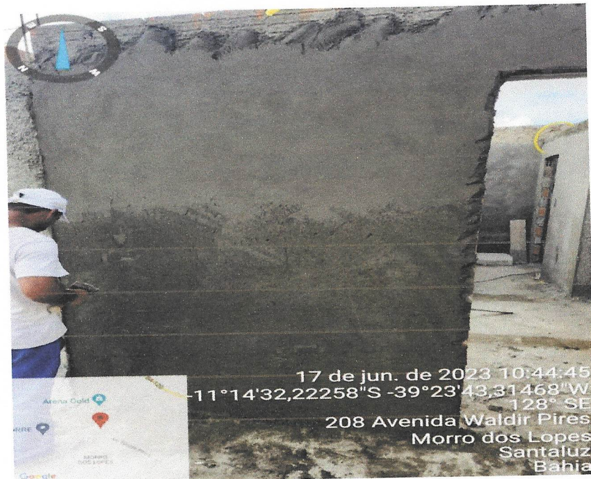
Foto 32- REBOCO DA ALVENARIA E DESFORMA DA LAJE DA COZINHA
