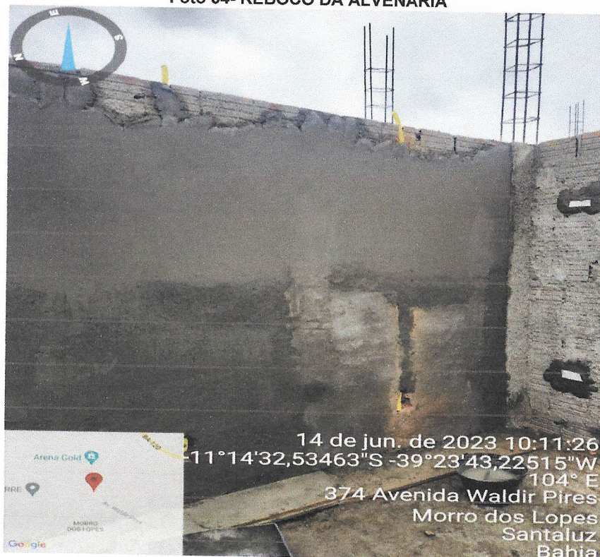
Foto 34- REBOCO DA ALVENARIA
