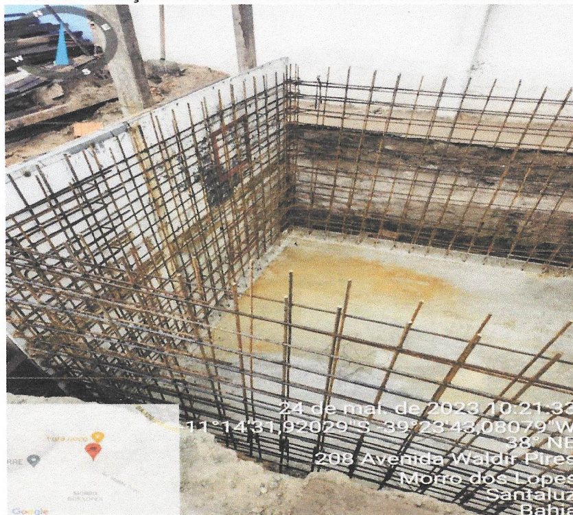
Foto 25- ARMAÇÃO DAS FORMAS METÁLICAS PARA CONCRETAGEM
