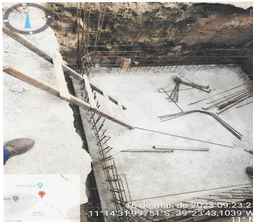
Foto 20- CONCRETAGEM DO RESERVATÓRIO
