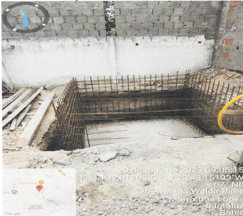
Foto 24- ARMAÇÃO DAS FERRAGENS DO RESERVATÓRIO
