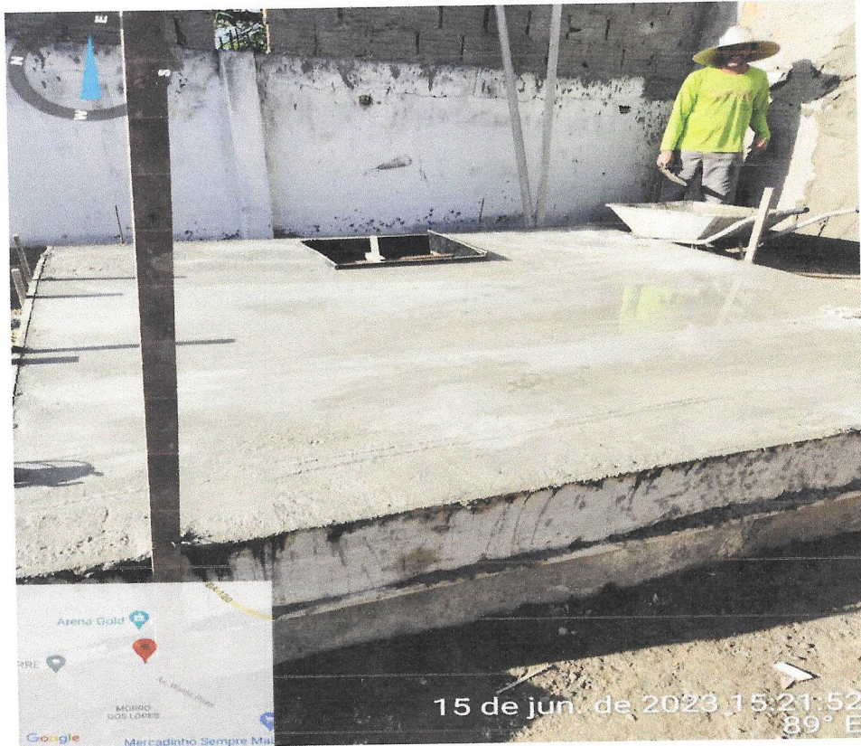
Foto 30- REBOCO DO RESERVATÓRIO
