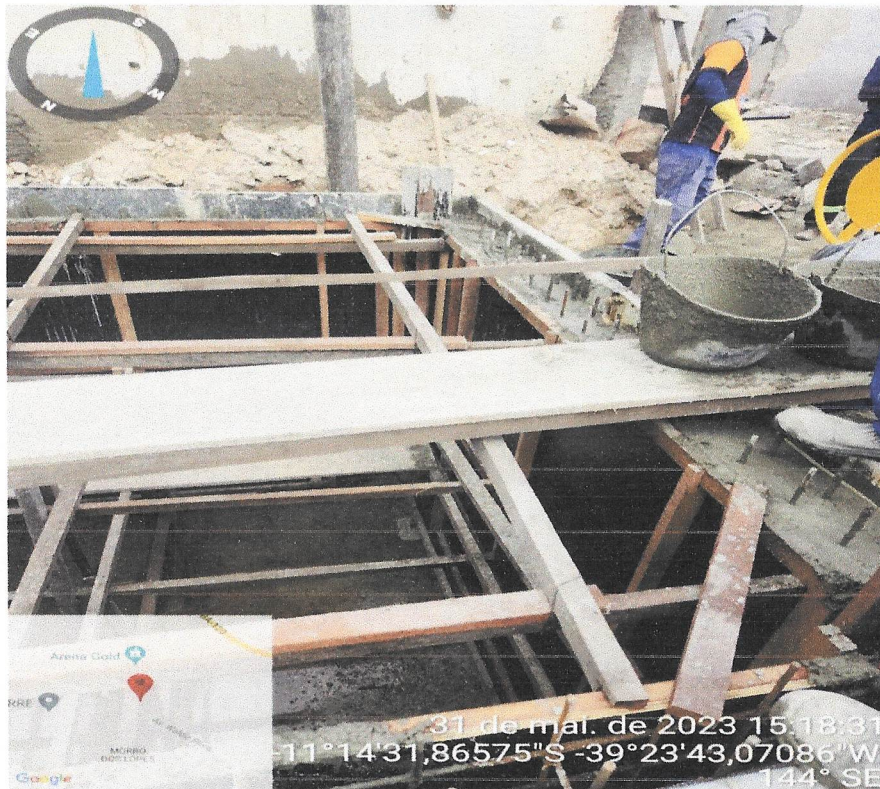
Foto 28- ARMAÇÃO DA FERRAGEM E DA FORMA DO RESERVATÓRIO
