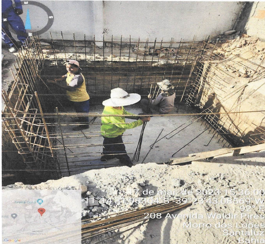
Foto 23- ARAMAÇÃO DAS FERRAGENS DA PAREDE LATERAL DO RESERVATÓRIO
