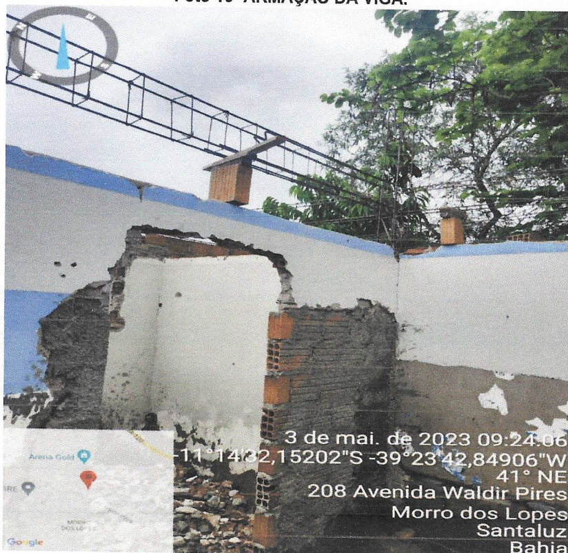
Foto 16- ARMAÇÃO DA VIGA.
