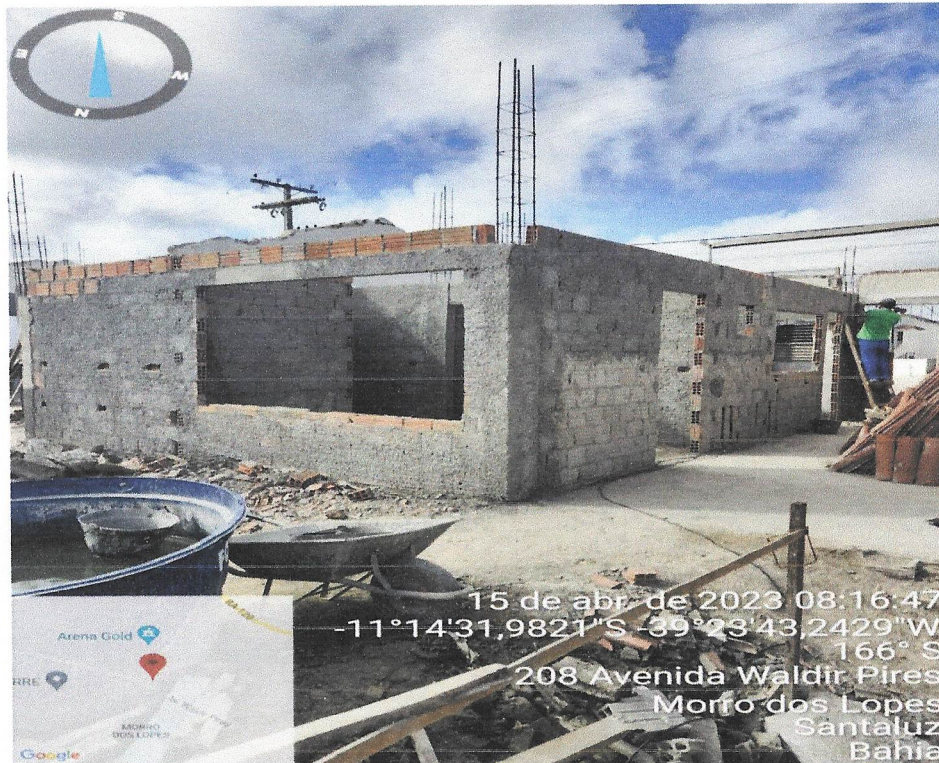
Foto 03 – CHAPISCO DAS PAREDES.
