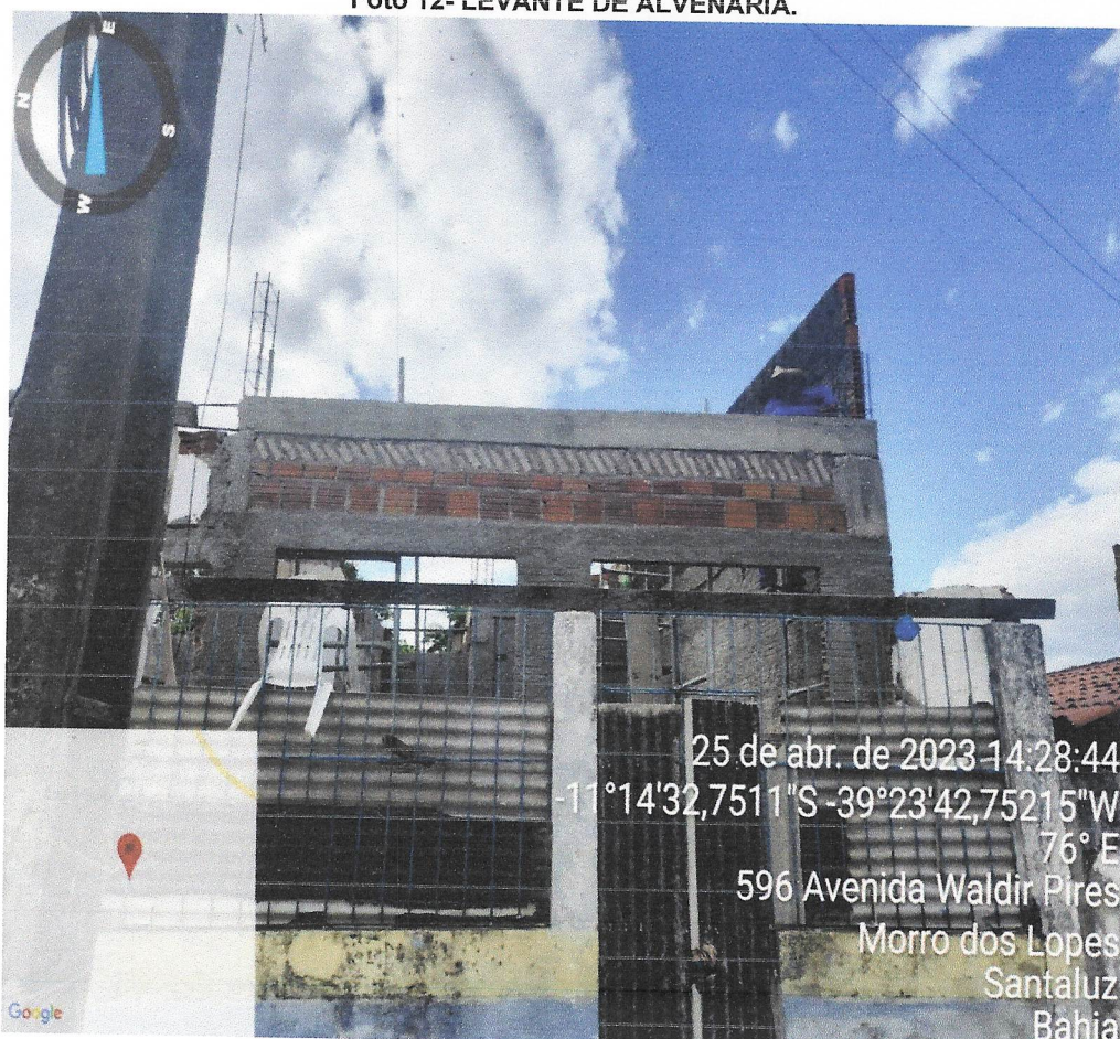
Foto 12- LEVANTE DE ALVENARIA.
